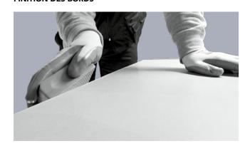
Les arêtes peuvent être poncées à la main à l'aide d'un bloc mousse abrasif jourmant ou du papier de verre. En ponçant légèrement l'arête de la dalle, on peut obtenir un chant légèrement arrondi. Un ponçage répété permet d'obtenir un effet biseauté.
