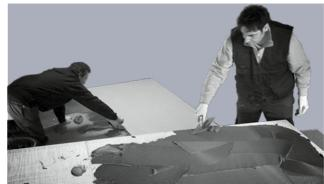
Appliquer de la colle sur le support et sur le dos de la dalle en l'étalant régulièrement sur toute la surface à recouvrir, à l'aide d'une truelle crantée avec dents inclinées (6 mm), par exemple la truelle Raimondi art.184HFV6. Étaler ensuite la colle également sur le dos de la dalle à l'aide d'une truelle crantée (3 mm). Lors de la pose au sol, n'oubliez pas d'étaler de la colle supplémentaire autour des bords de
