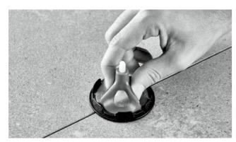
Grâce à ses caractéristiques de légèreté, de flexibilité et de haute précision, le grès cérame laminé permet une pose simple et efficace, en utilisant ou non des systèmes de mise à niveau
